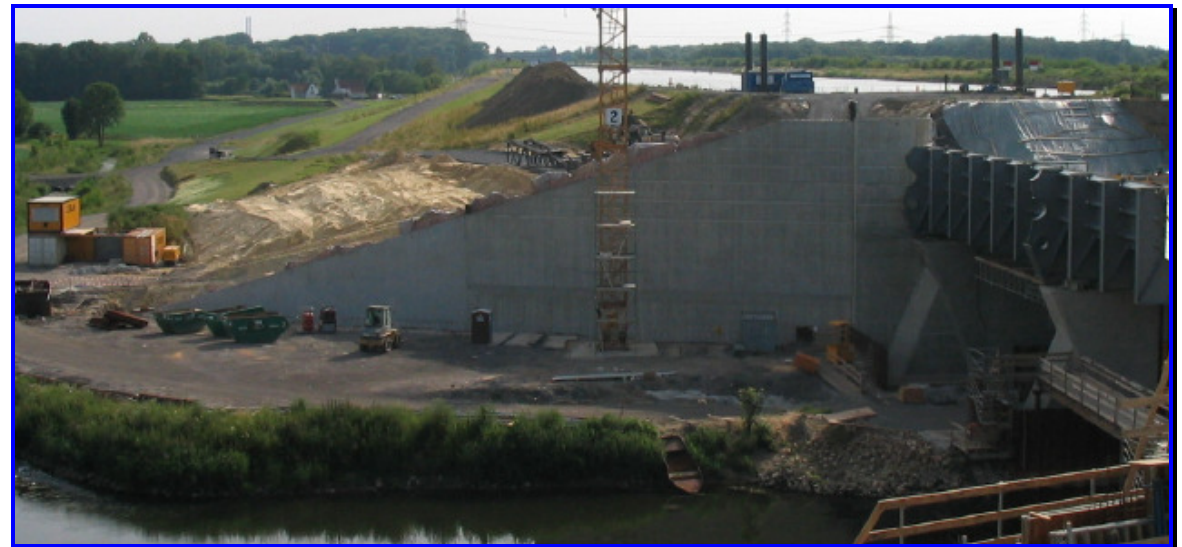
Bild links, Stützwand im Bauzustand
