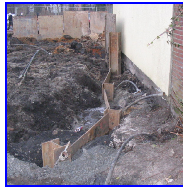
Bild 1, Urgelände, eingesetzte Bohrträger mit bereits eingedrücktem Stahlplattenverzug
