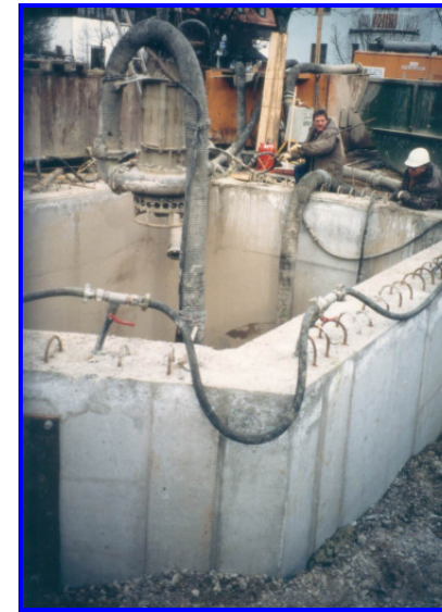
Absenkvorgang mit Baggerpumpe
